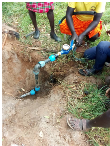
Watermeters zijn geplaatst
